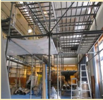
ホールの工事の様子です。
